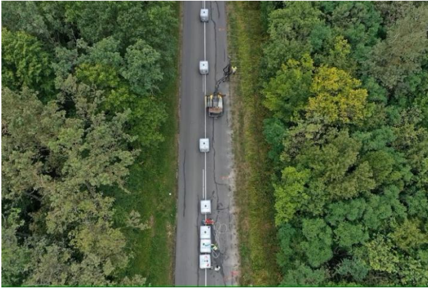
Figure 4. Vue aérienne de l'injection des solutions de biocimentation BCEM (© Medusoil SA)
