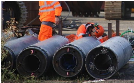
Figure 3. Éléments de pieux creux utilisés lors de l'essai sur le terrain
