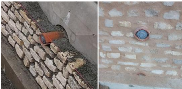
Figure 14. Revêtement en moellons avec réservation
