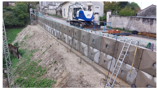
Figure 11. Pose des écaïlles
