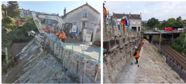
Figure 9. Forage et terrassement
