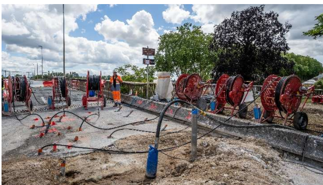
Figure 8. Injection Biocalcis® en cours
