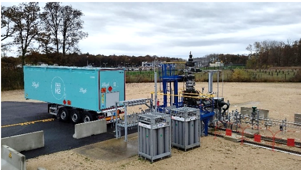
Figure 7 : Camion d'hydrogène à proximité de la tête du puits EZ53.
