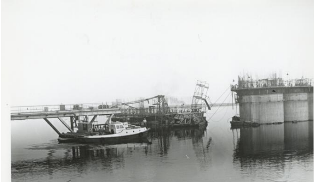
Figure 3. Schémas et photographies de travaux avec de haut en bas, construction des embases à sec et surélévation des caissons à l'aide d'une estacade (source : archives du Port du Havre).
