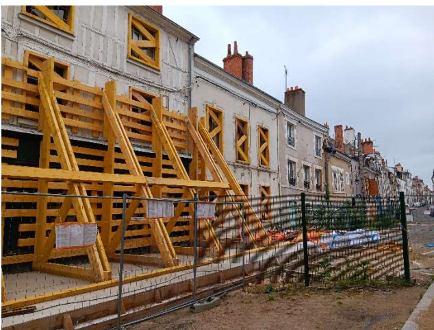
Figure 2. Mesures préalables à la démolition
