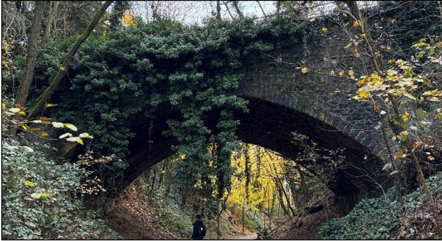
Figure 8. Exemple d'un pont diagnostiqué
