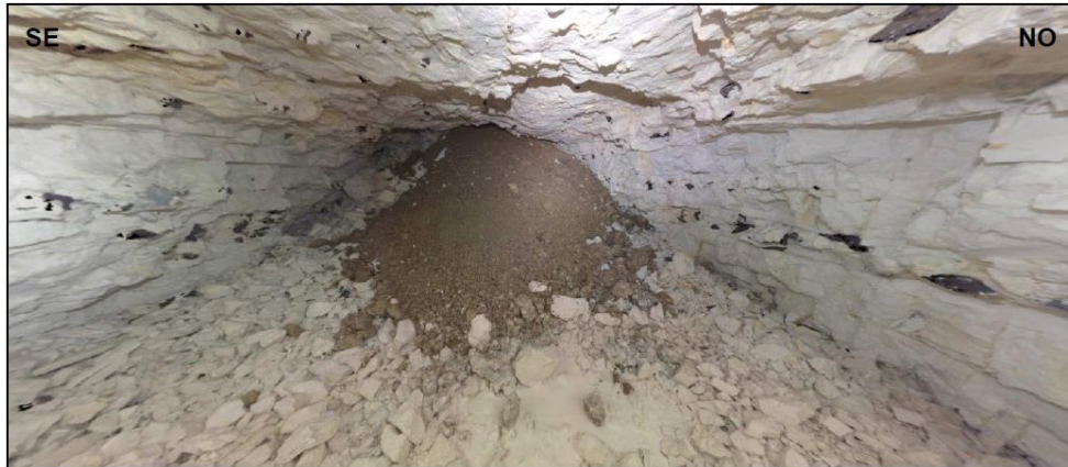
Figure 11: Photographie, depuis l'un des forages, d'une partie de la cavité obstruée par les éboulis (craie et limons) de l'un des effondrements observés en surface (IGECAV)
