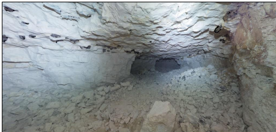
Figure 10: Photographie, depuis le forage SD205, du réseau souterrain (IGECAV)
