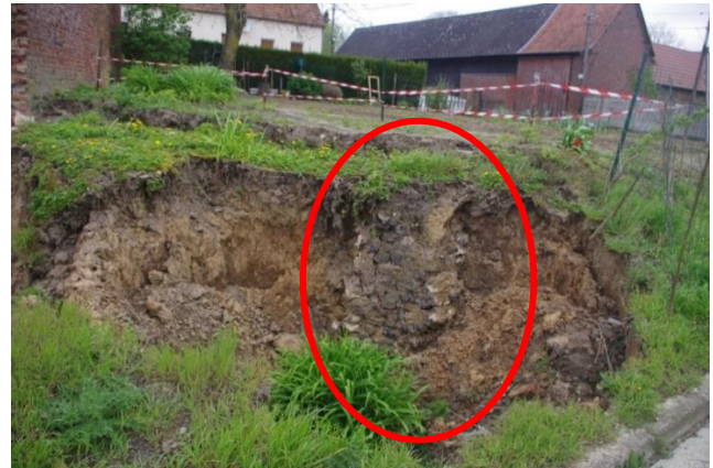
Figure 3 : Ouvrage circulaire avec revêtement en silex observé dans l'un des effondrements
