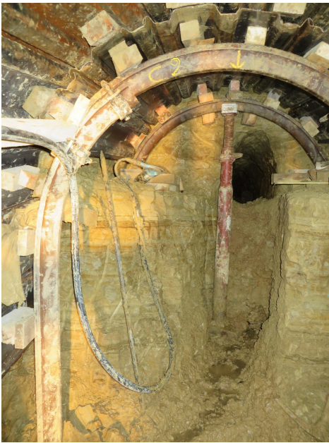
Figure 7. Vue de la galerie après dégagement
