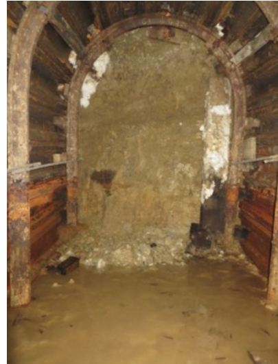
Figure 8. Front de taille aval
