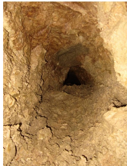
Figure 6. Galerie écroulée
