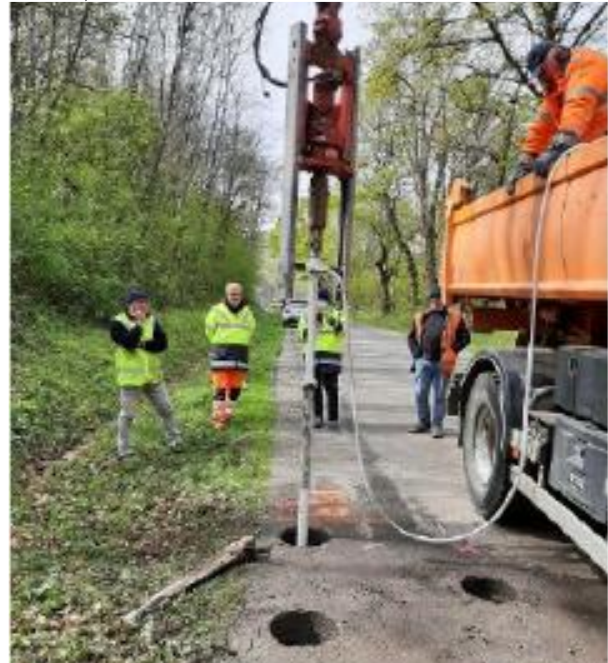
Figure 8. Planche d'essai 2021 avec deux lignes de puits verticaux en quinconce, en rive de chaussée de la RD 9
