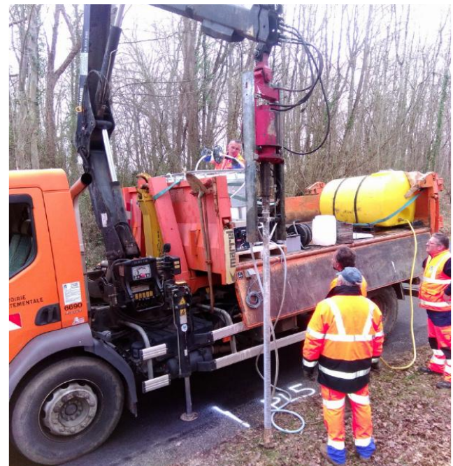
Figure 7. Premiers tests in situ sur accotements, 2019-2020
