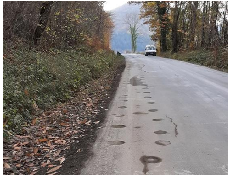
Figure 11. RD 9, état de surface de la rive après réalisation des puits
