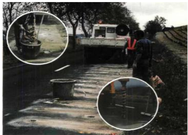
Figure 1. 1990, puits de chaux réalisés à Laffite-Toupière, RD 52 (Dpt. 31)
