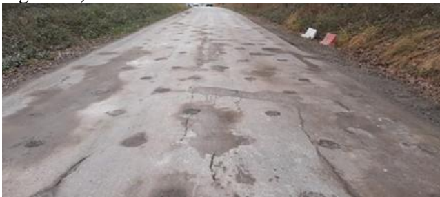
Figure 10. RD 8, état de surface de la chaussée après réalisation des puits
