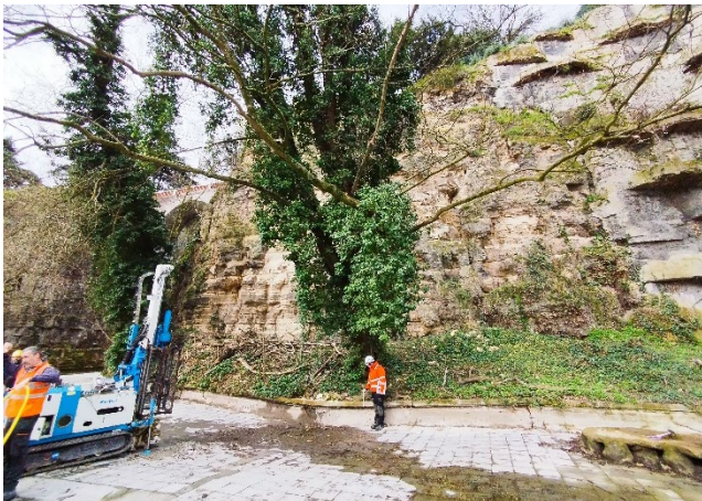
Figure 5. Affaissement près de la paroi est de l'île au moment de son investigation par sondage (BRGM)
