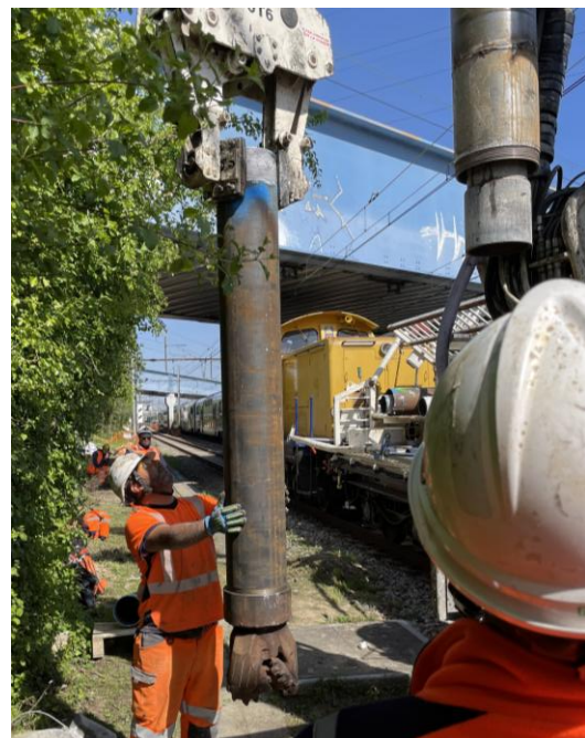
Figure 6. Micropieux autoforé en Hi'Drill® avec tricône perdu.
