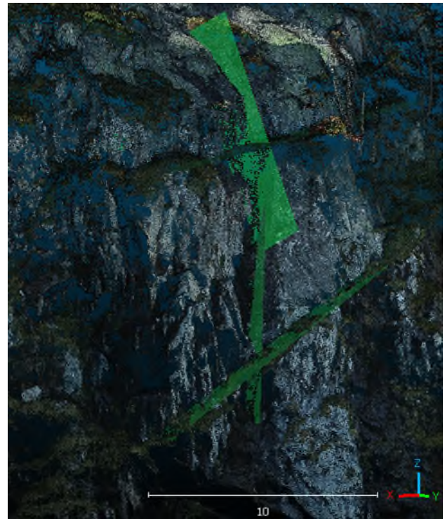
Figure 4 : Illustration de la prise de pendage de plans dans le thalweg au niveau d'une falaise constituant l'extrémité du massif de fondation en rive gauche du barrage, à partir du logiciel CloudCompare
