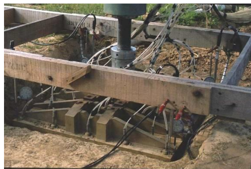
Figure 4 Semelle carrée instrumentée (photographies Canépa)
