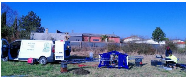
Figure 15. Vue générale de l'essai sur le site d'Aulnat (22/03/2022)
