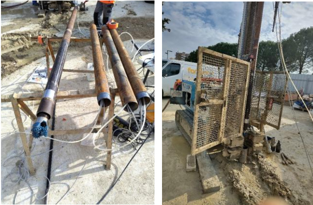
Figure 12. Préparation de la sonde et mise en place par la sondeuse
