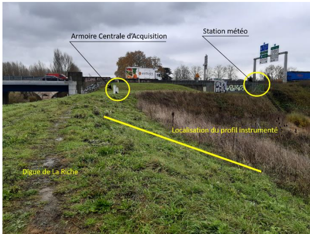
Figure 5. Vue du site en 2024 avec localisation de la station météo, du profil instrumenté et l'armoire de centralisation
