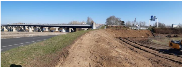
Figure 2. Vue d'ensemble du site avec de gauche à droite, la Loire, l'avenue Proudhon, la digue et la boucle intérieure de l'échangeur, objet des travaux de renforcement
