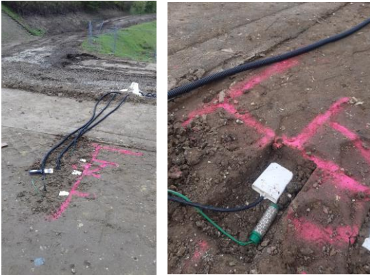
Figure 10. Pose des sondes TDR (en blanc) et succion (en vert) n°9, 8 et 7 à mi-hauteur de la digue (niveau 3). Le trait à la bombe en haut de la photo matérialise la position future du talus après enlèvement du mètre excédentaire.
