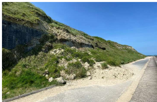
Figure 6. Exemple de zone mise en évidence (zone A)
