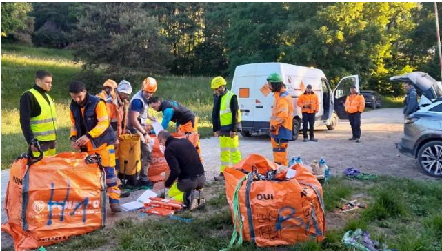
Figure 10 . Répartition des explosifs avant héliportage
