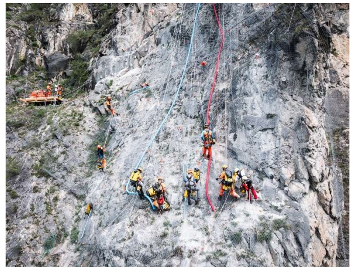
Figure 12 . Chargement des explosifs en falaise
