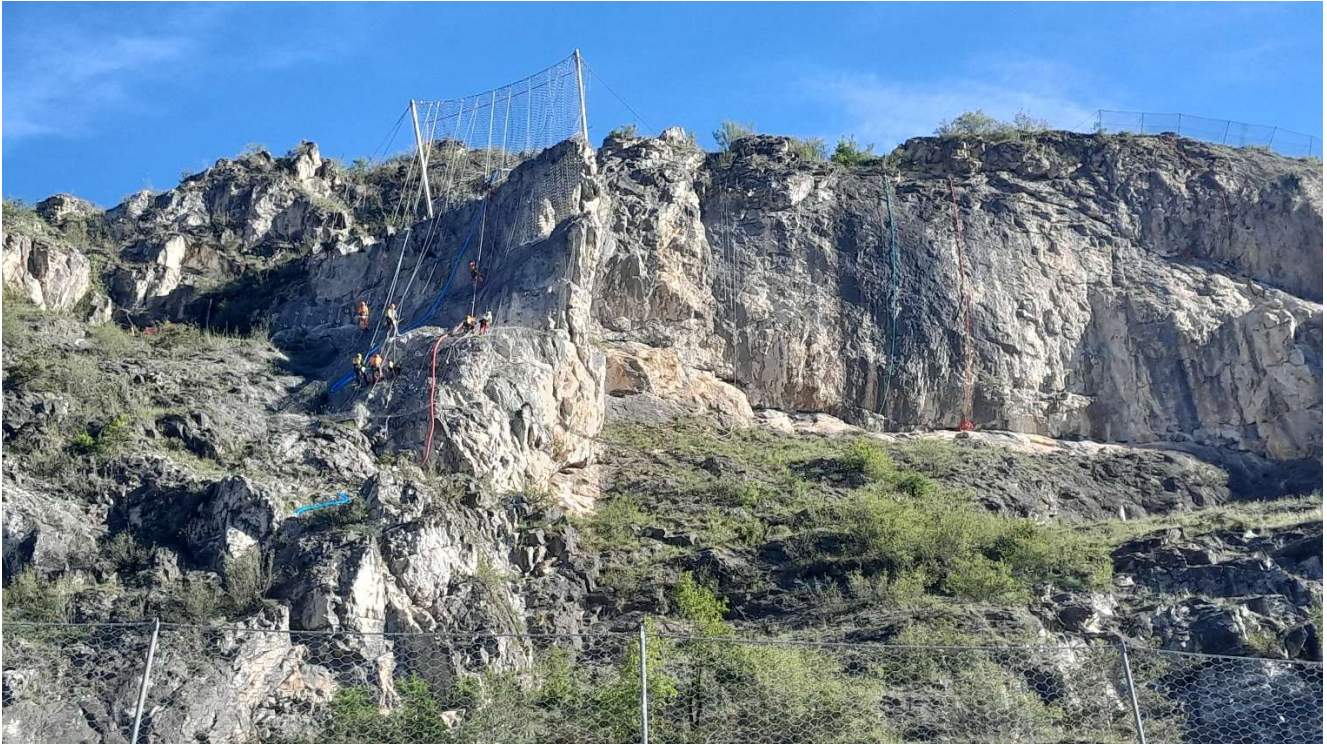
Figure 8 . Vue du portique positionné au-dessus de la masse rocheuse instable
