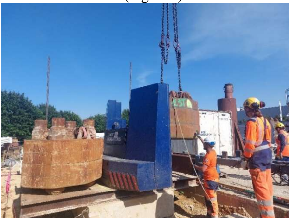
Figure 9. Mise en place des lests pour l'essai de chargement horizontal
