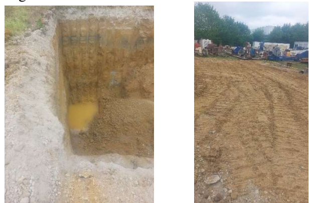
Figure 3. Fosse réalisée à la pelle et zone remblayée
