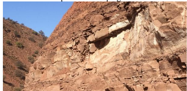
Figure 14 : talus de grès fracturé avec chute de dièdre
