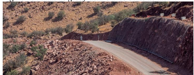
Figure 15 : installation d'un filet suspendu pour contrôler les chutes de blocs
