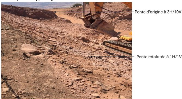
Figure 12 : talus du corridor de la conduite forcée en cours de reprise
