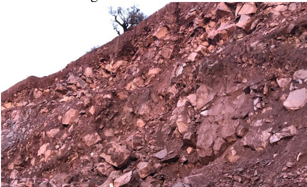
Figure 17 : talus de colluvions
