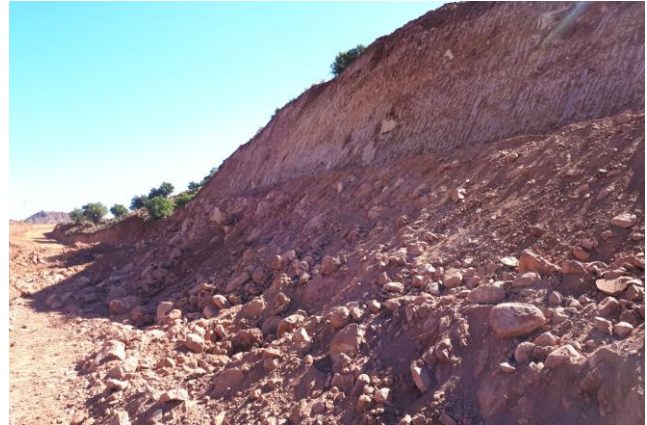
Figure 8 : talus présentant des alluvions
