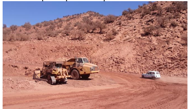
Figure 5 : usage des routes par les engins de chantier et les habitants des douars
