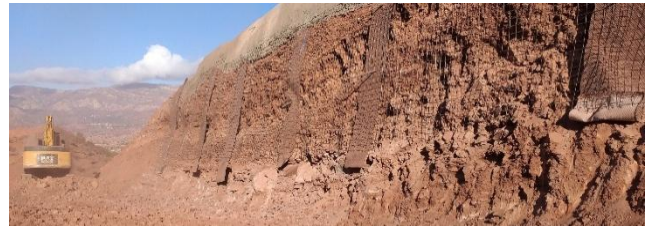
Figure 13: Réalisation d'un confortement en béton projeté pour limiter l'altération des roches
