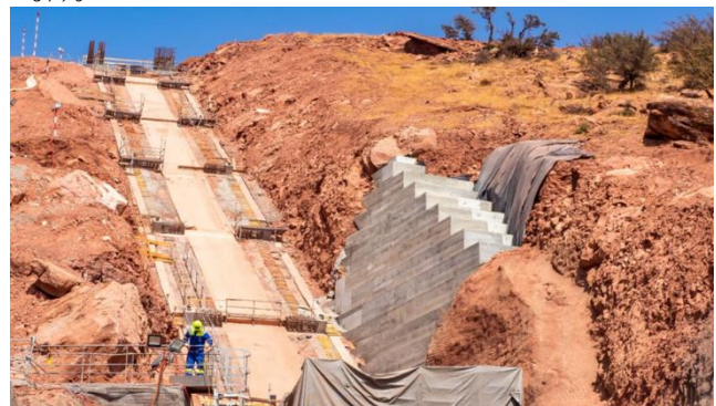
Figure 20 : Confortement mur poids en béton
