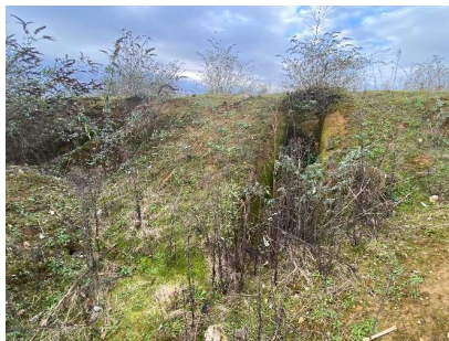
Figure 3. Vue du remblai traité à la chaux prise en 2025
