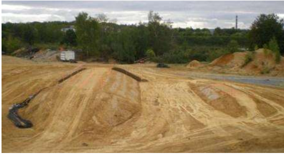
Figure 2. Vue d'ensemble des digues, prise en 2011, après leur construction (traitée à la chaux à gauche et non traitée à droite)
