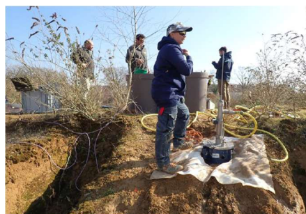
Figure 6. Réalisation d'un essai JET sur le talus nord-ouest
