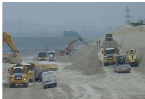
Figure 7. Atelier de traitement de la craie au liant hydraulique routier et de reconstitution du talus.
