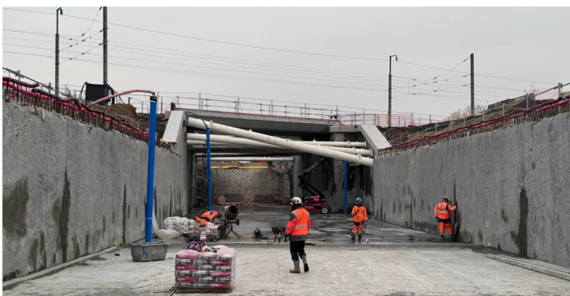
Figure 11. Illustration du chantier après terrassements
