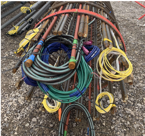
Figure 4. Capteurs d'auscultation thermique de l'intégrité (TIP) installés sur une cage d'armature de pieu O-Cell® sur le site B.
