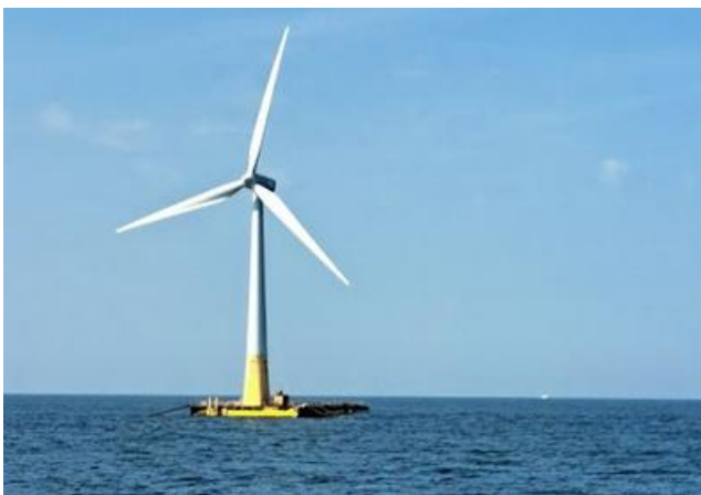
Figure 1. Floatgen, la première éolienne flottante française (2MW) installée en 2018 au large du Croisic. Crédit photo : O. Jenck.
