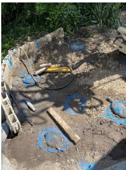
Figure 11: Repérage en tête du puits de la position des inclusions en jet grouting réalisées
