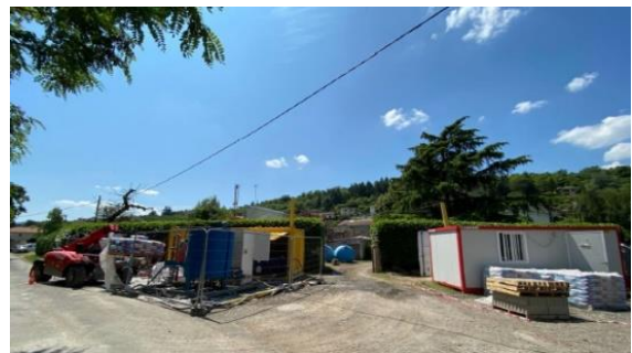
Figure 9: Atelier de jet grouting et base vie à l'entrée de la propriété
