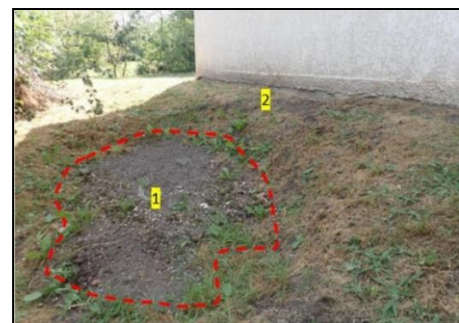
Figure 3 : Vue du désordre et de la façade du garage en septembre 2019 (1) Zone de la dépression (2) Limite du garage sur radier (source GEODERIS)
