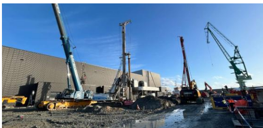
Figure 9. Photographie de la coactivité sur la phase 2
