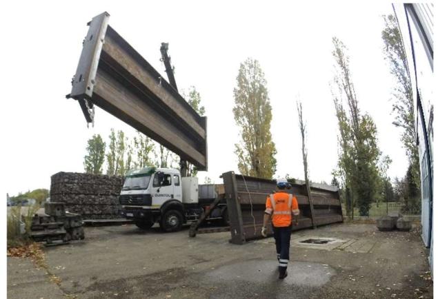
Figure 24. Déploiement d'un écran d'urgence 500kJ
