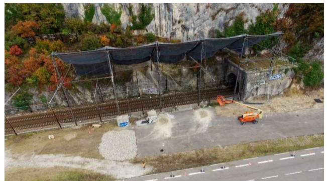
Figure 23. Galerie de protection sur voie TGV
