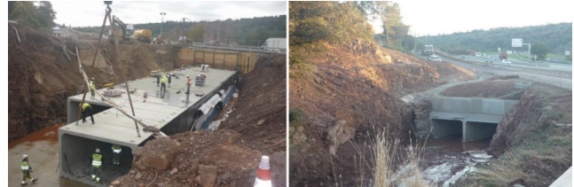
Figure 7. Reconstruction de l'ouvrage et situation de réouverture des 2 sens de l'autoroute.
