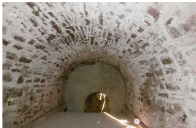
Figure 16. Rejointoiement de voûtes maçonnées.
