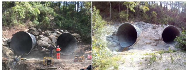
Figure 14. Étanchéification d'entonnement aval.
