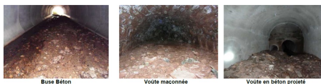
Figure 12. Curage des ouvrages encombrés.
