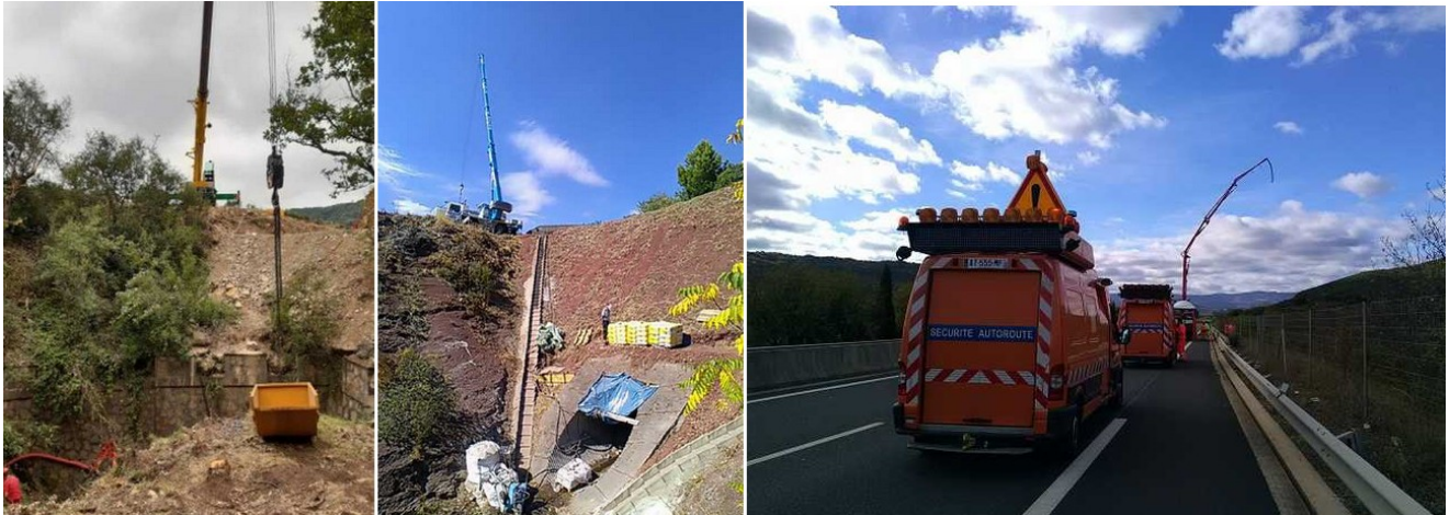
Figure 19. Moyens d'accès aux ouvrages et mesures d'exploitation spécifiques sur l'autoroute A75 pour la bonne réalisation des travaux.
