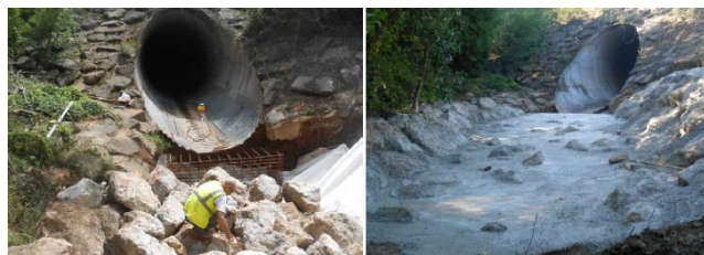
Figure 13. Lestage et dispositifs pare-affouillements.
