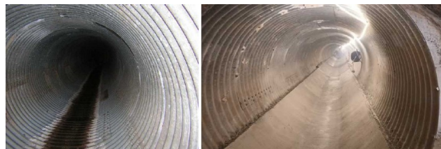
Figure 15. Réalisation de radiers de protection.
