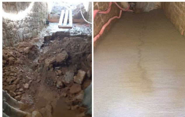
Figure 17. Réparation/reconstitution d'un radier.
