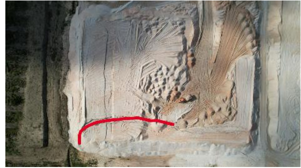
Figure 12. Photos d'une rupture circulaire dans une zone de stockage non traitée
