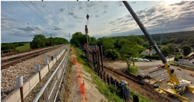
Figure 13. Photo du chantier le 4 juin 2025
