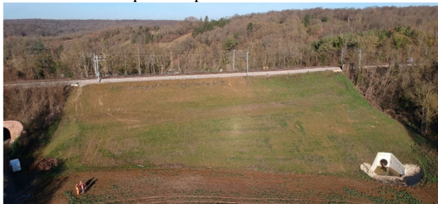
Figure 1. Vue générale du remblai (talus sud-est)
