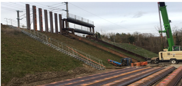
Figure 4. Clouage par palplanches côté V1 mars 2020
